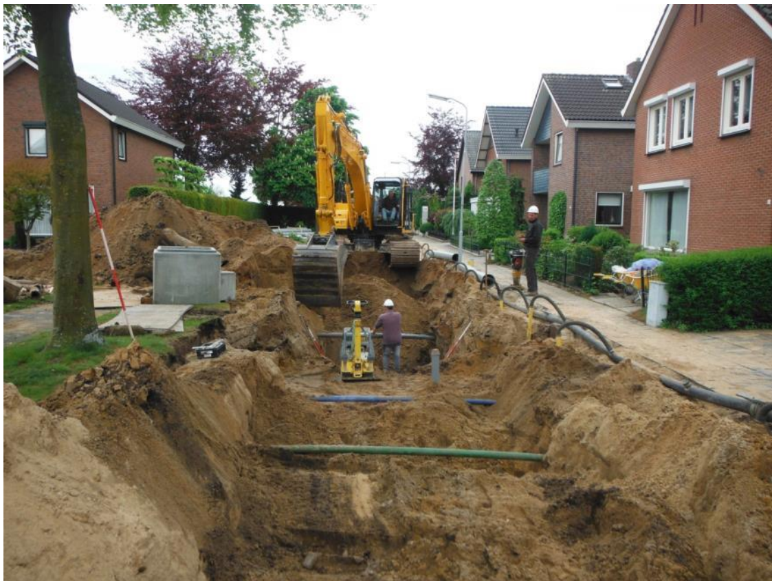
Afbeelding 39: Impressie werkzaamheden nabij profiel 16
