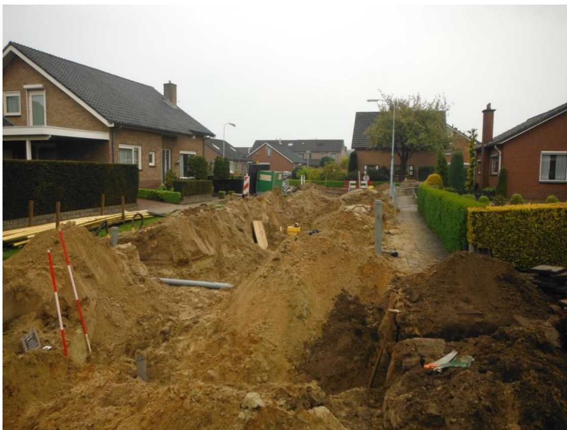
Afbeelding 23: Impressie werkzaamheden nabij profiel 8
