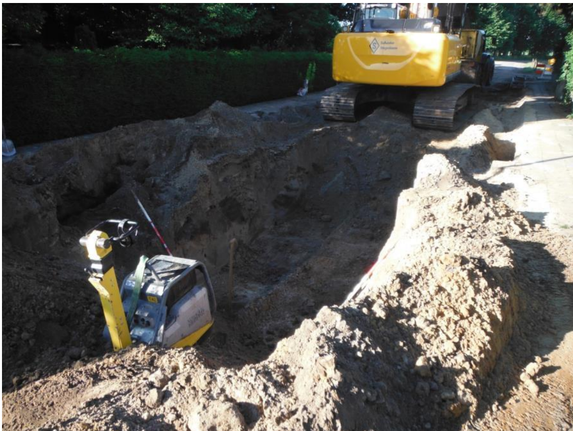
Afbeelding 79: Impressie werkzaamheden nabij profiel 36
