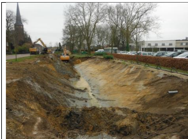
Graafwerkzaamheden noordoostelijke deel gracht
