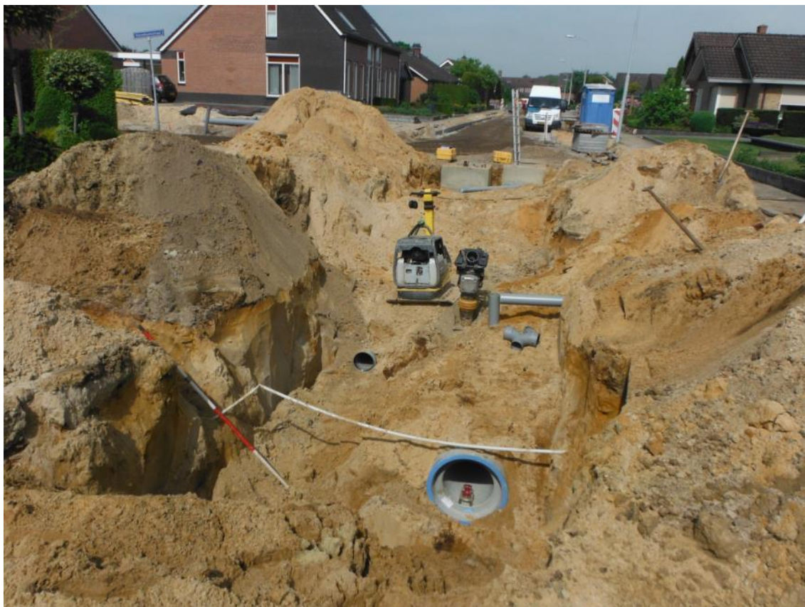
Afbeelding 47: Impressie werkzaamheden nabij profiel 20
