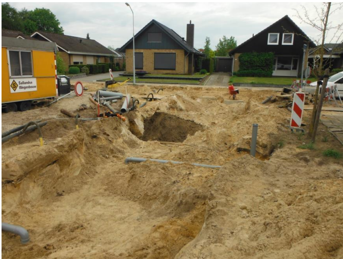
Afbeelding 35: Impressie werkzaamheden nabij profiel 14
