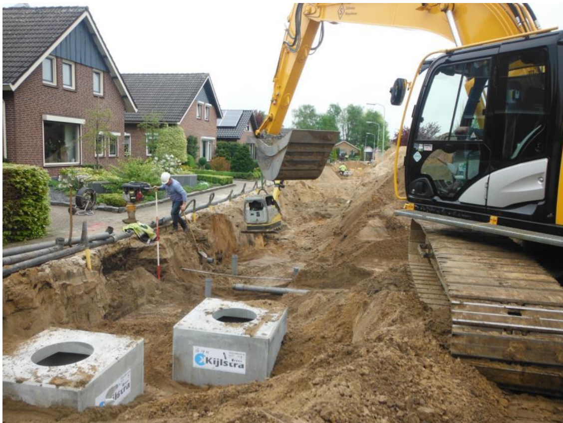
Afbeelding 33: Impressie werkzaamheden nabij profiel 13
