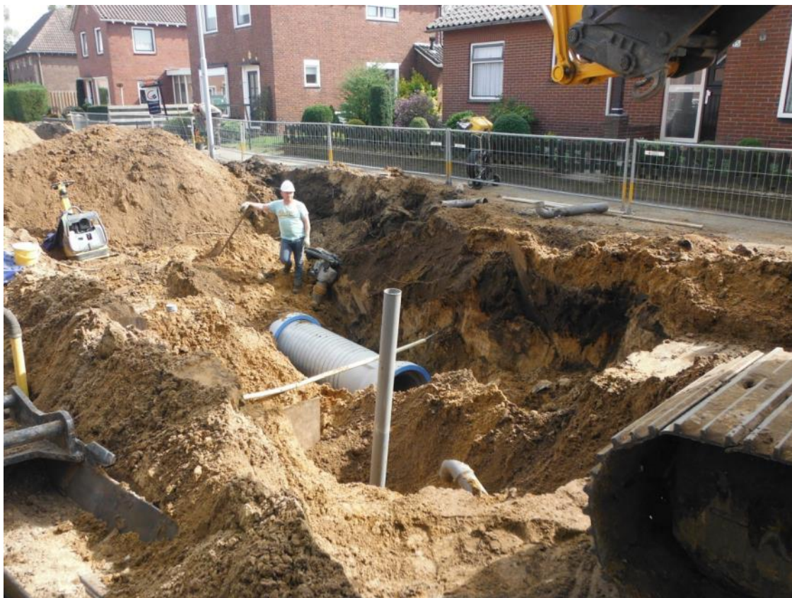
Afbeelding 15: Impressie werkzaamheden nabij profiel 4
