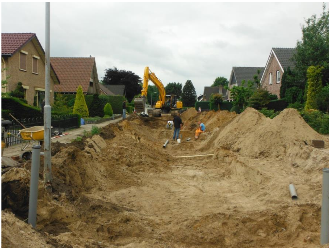
Afbeelding 69: Impressie werkzaamheden nabij profiel 31
