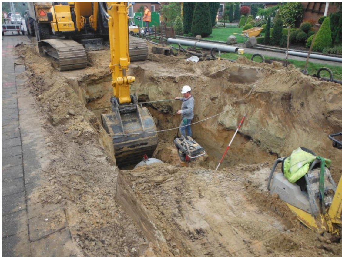
Afbeelding 25: Impressie werkzaamheden nabij profiel 9
