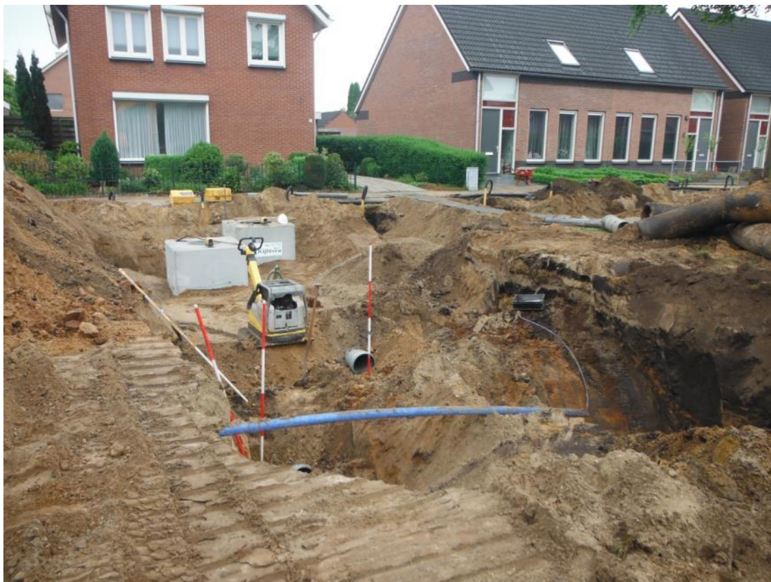
Afbeelding 43: Impressie werkzaamheden nabij profiel 18
