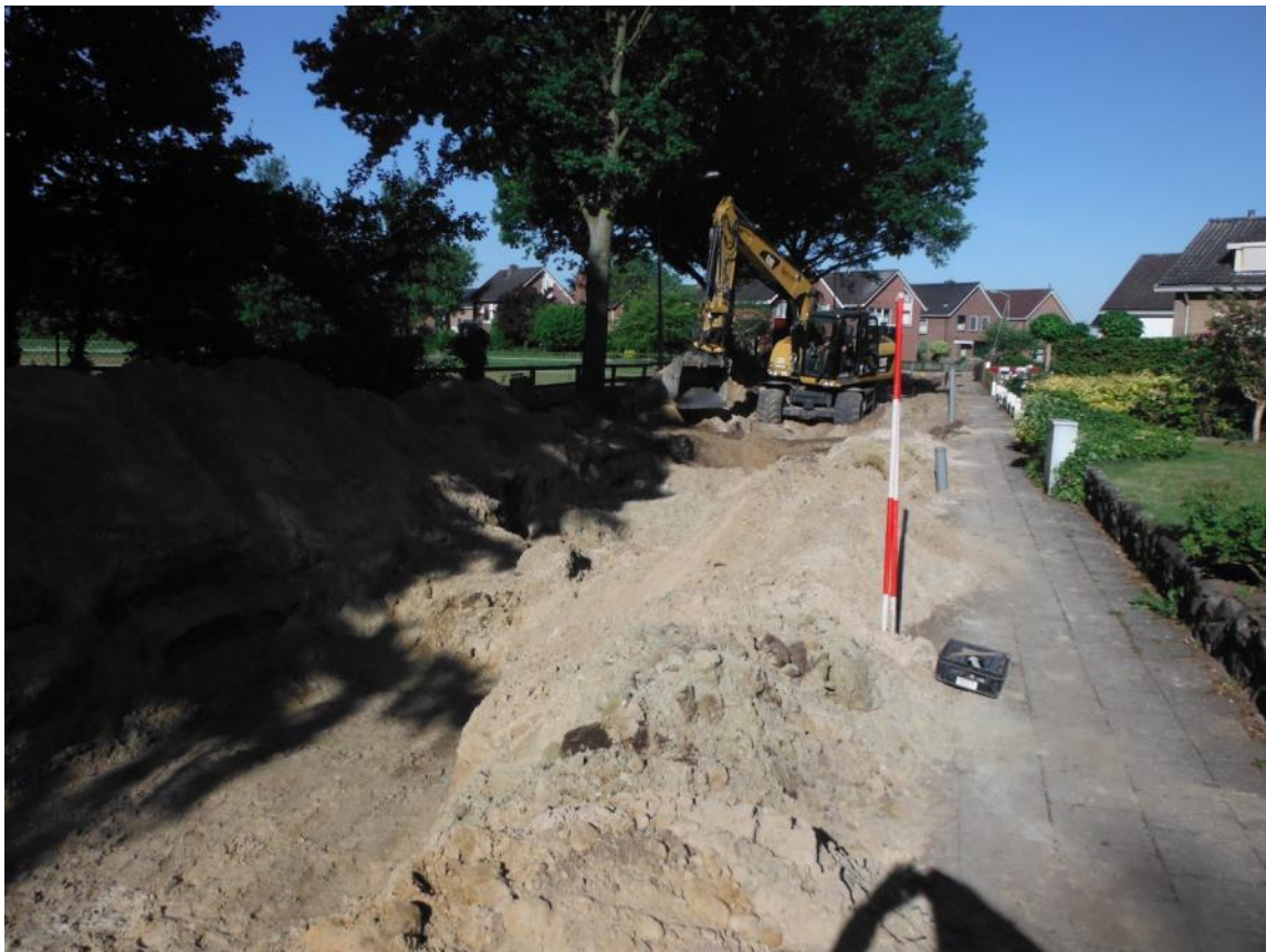
Afbeelding 57: Impressie werkzaamheden nabij profiel 25
