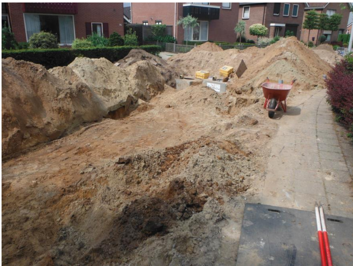
Afbeelding 51: Impressie werkzaamheden nabij profiel 22
