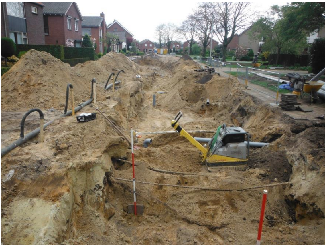
Afbeelding 17: Impressie werkzaamheden nabij profiel 5
