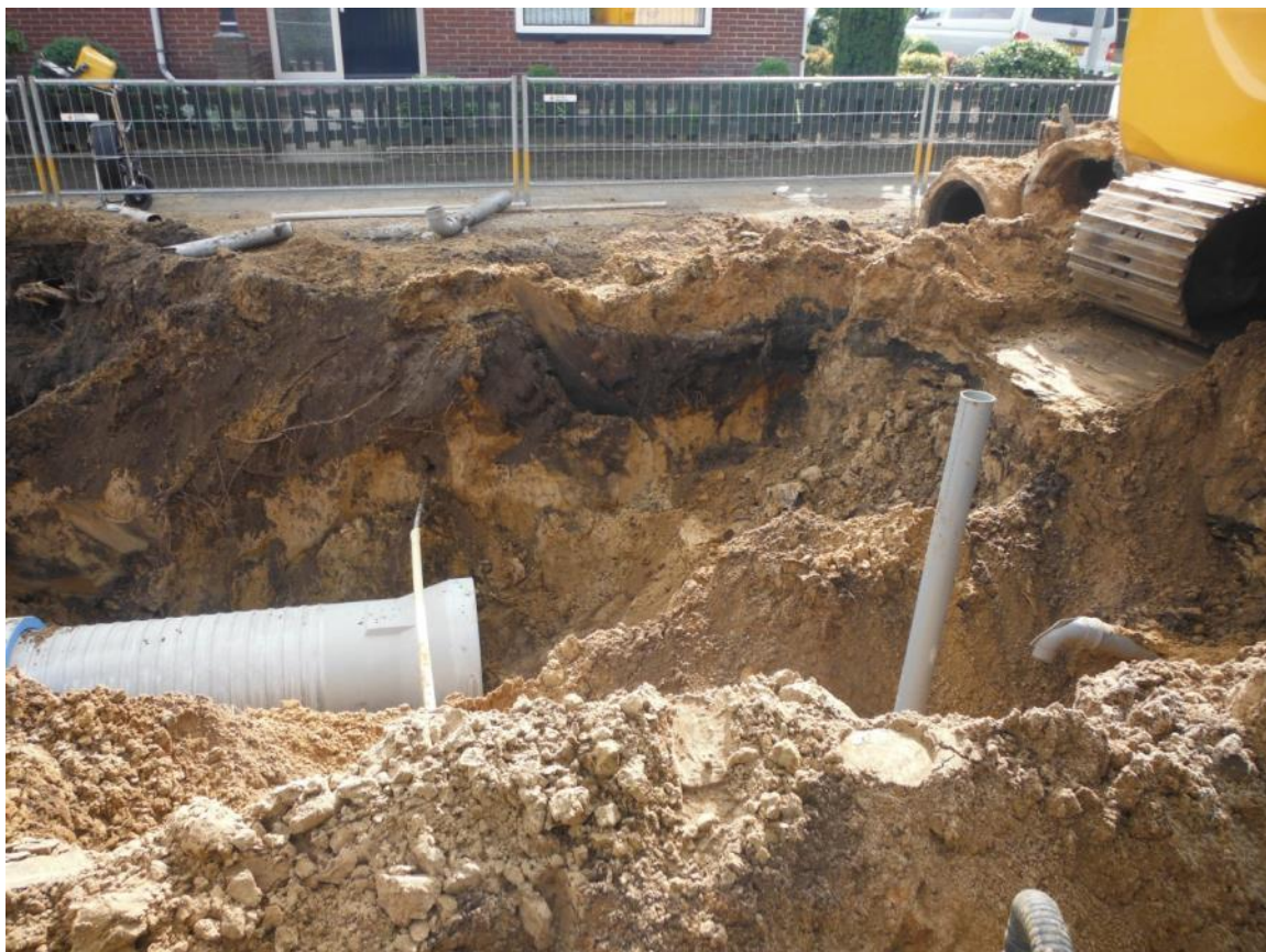
Afbeelding 93: Impressie werkzaamheden nabij profiel 43
