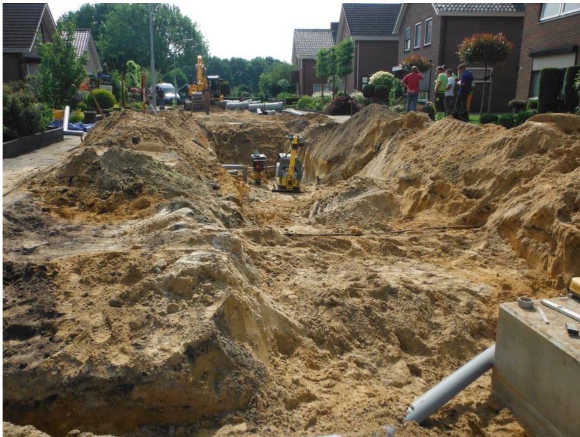
Afbeelding 49: Impressie werkzaamheden nabij profiel 21
