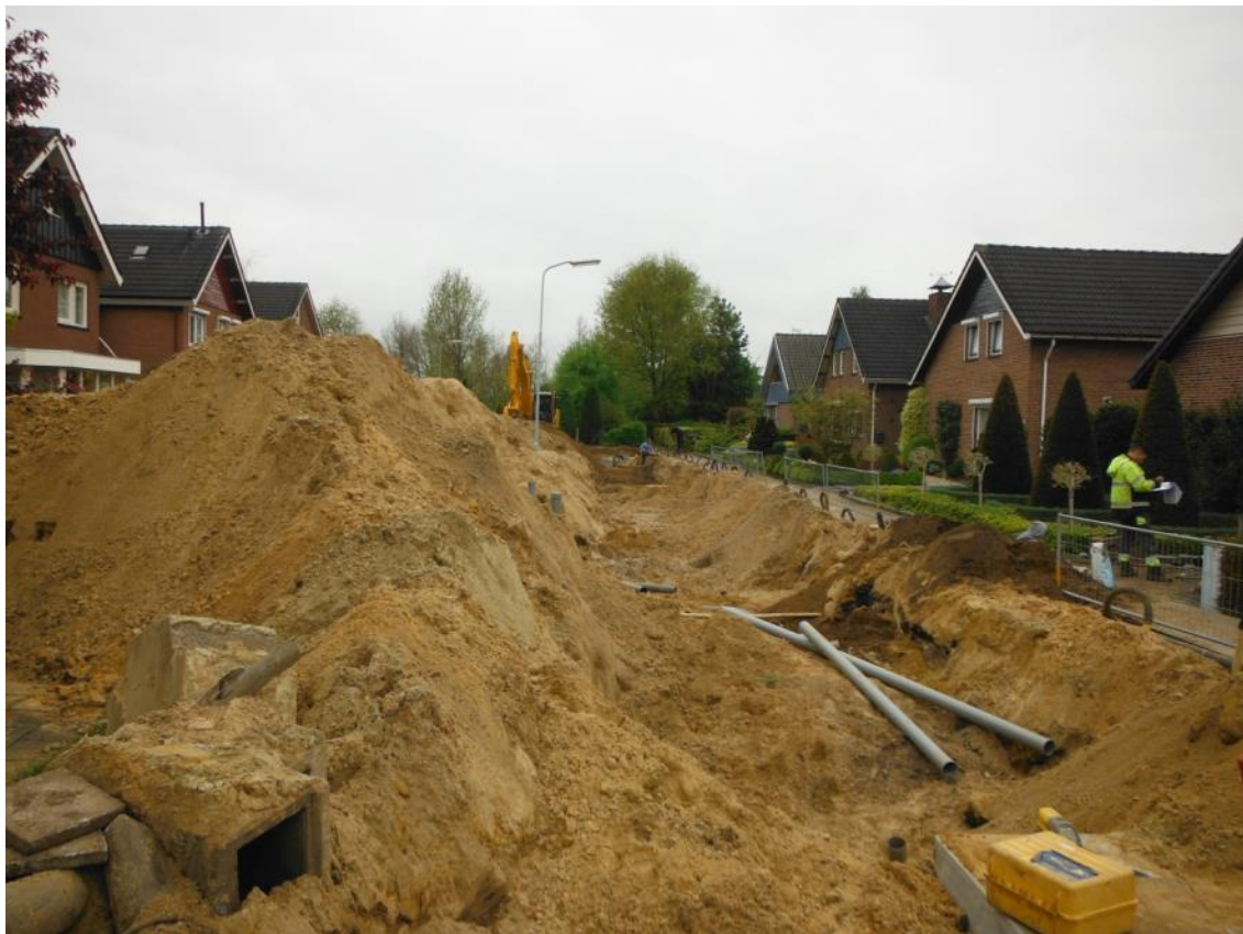
Afbeelding 27: Impressie werkzaamheden nabij profiel 10
