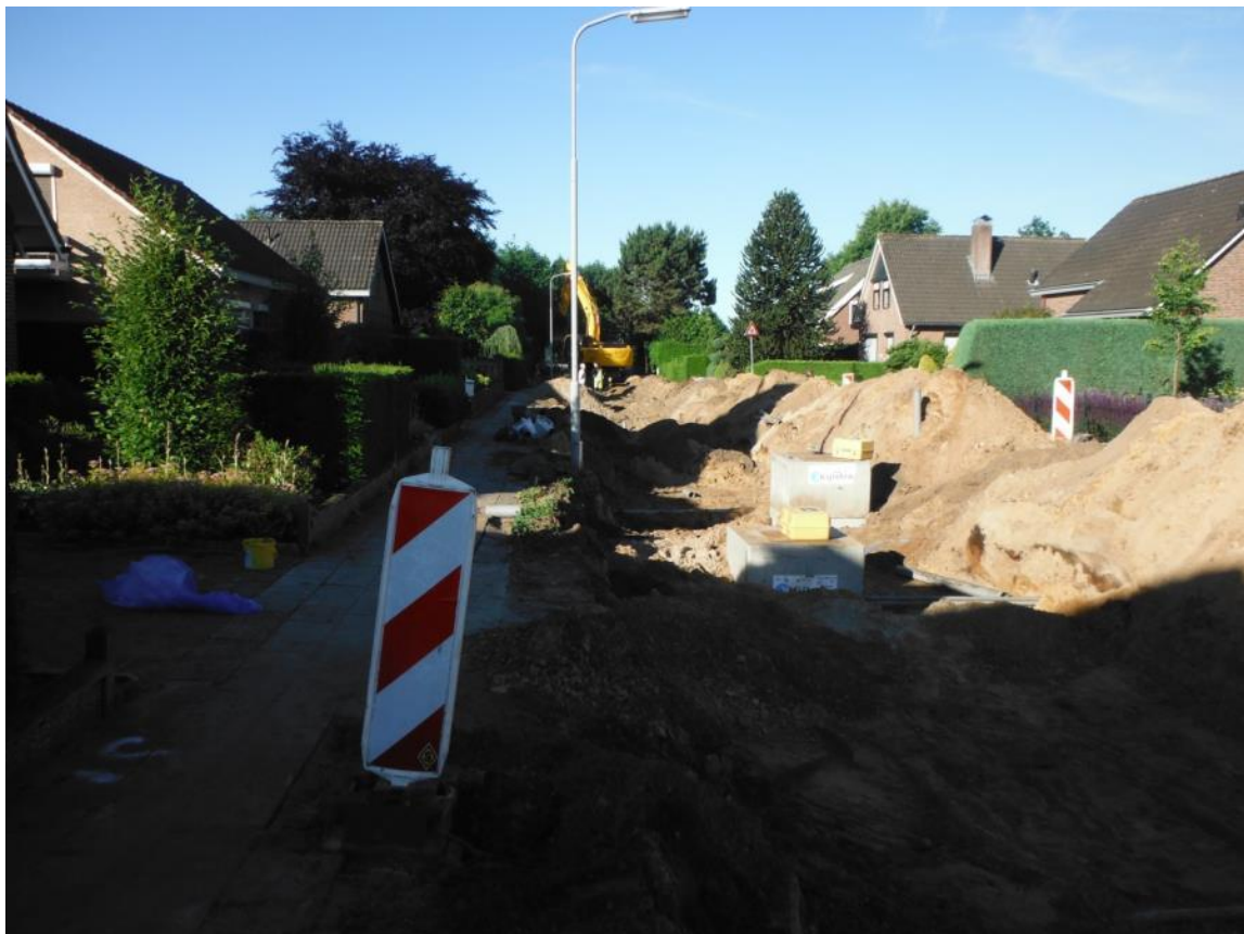
Afbeelding 75: Impressie werkzaamheden nabij profiel 34
