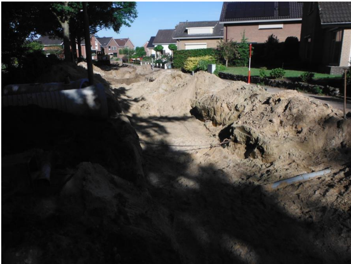
Afbeelding 61: Impressie werkzaamheden nabij profiel 27
