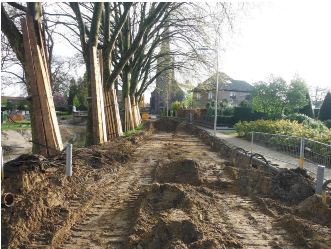
Afbeelding 19: Impressie werkzaamheden nabij profiel 6
