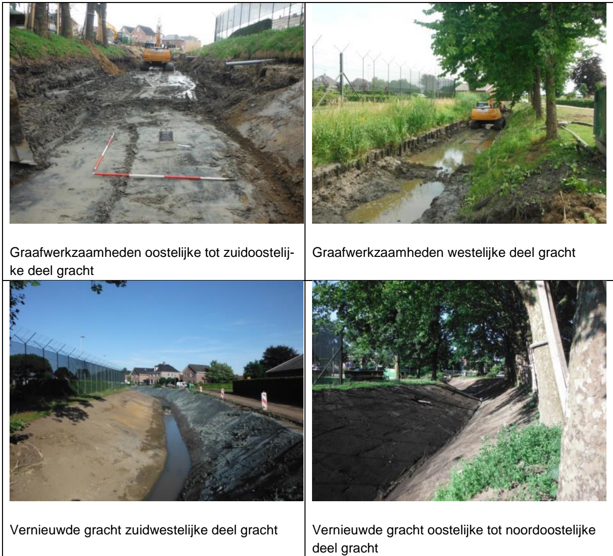
Afbeelding 11 Impressiefoto's van de werkzaamheden ter plaatse van de gracht
