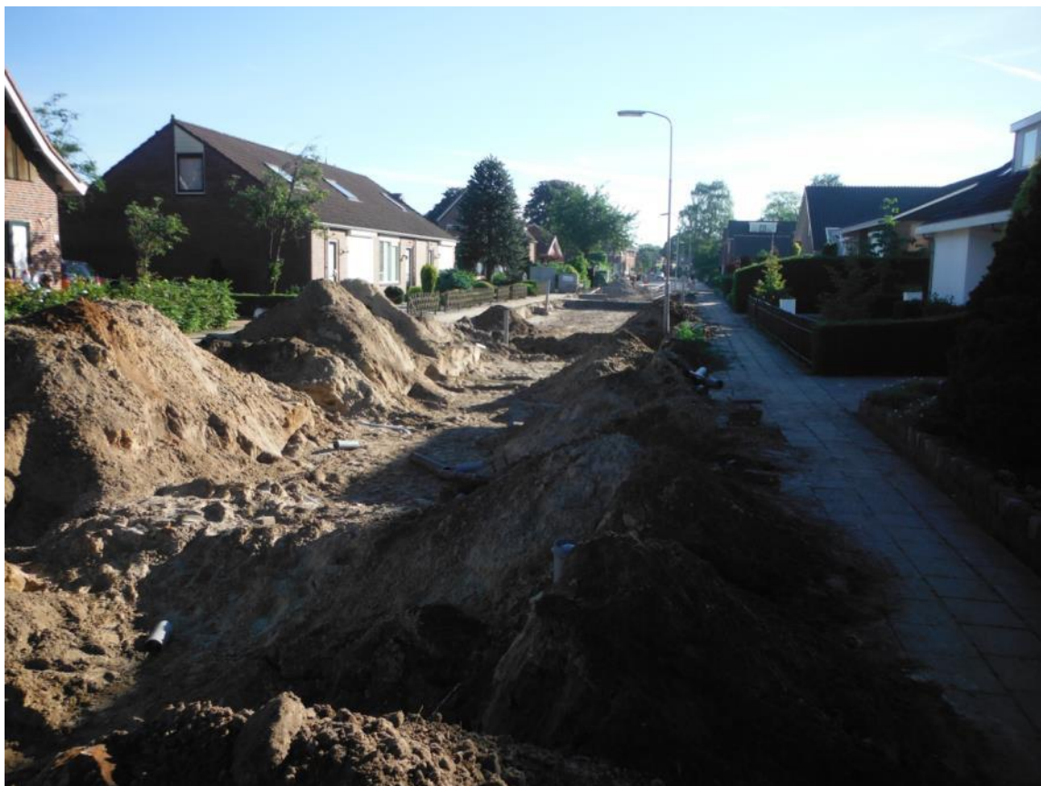
Afbeelding 73: Impressie werkzaamheden nabij profiel 33
