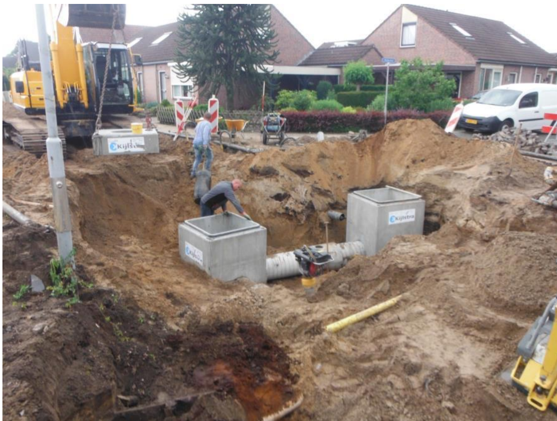
Afbeelding 65: Impressie werkzaamheden nabij profiel 29
