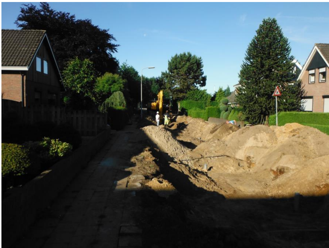
Afbeelding 77: Impressie werkzaamheden nabij profiel 35
