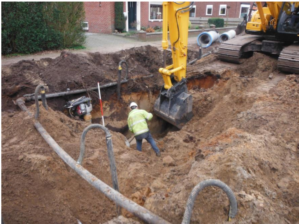
Afbeelding 81: Impressie werkzaamheden nabij profiel 37
