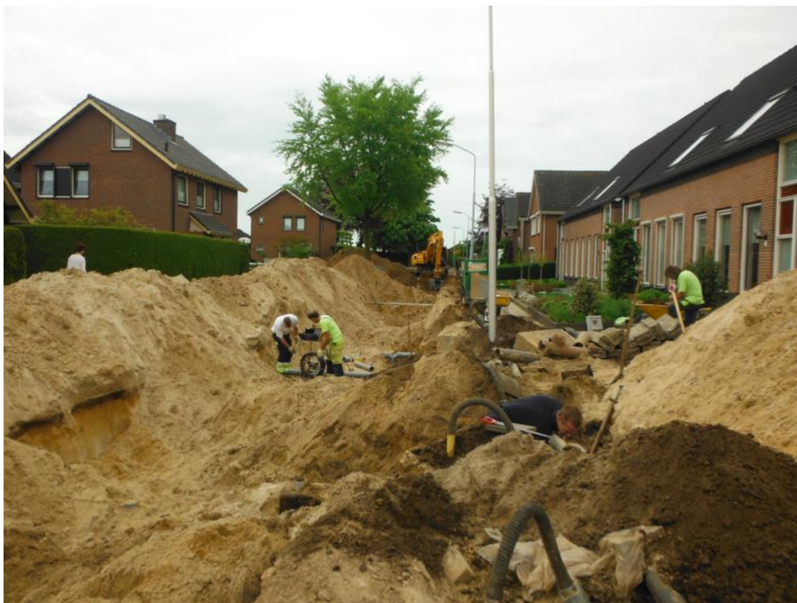
Afbeelding 37: Impressie werkzaamheden nabij profiel 15
