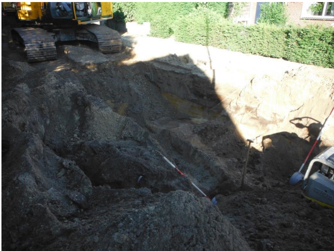
Afbeelding 91: Impressie werkzaamheden nabij profiel 42
