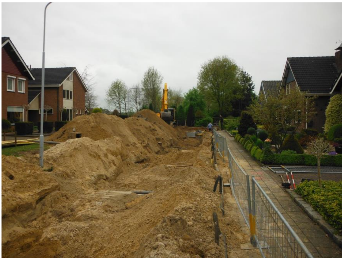
Afbeelding 29: Impressie werkzaamheden nabij profiel 11
