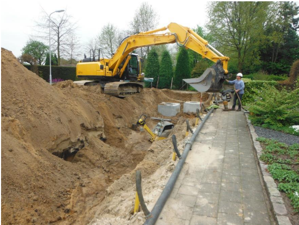
Afbeelding 31: Impressie werkzaamheden nabij profiel 12
