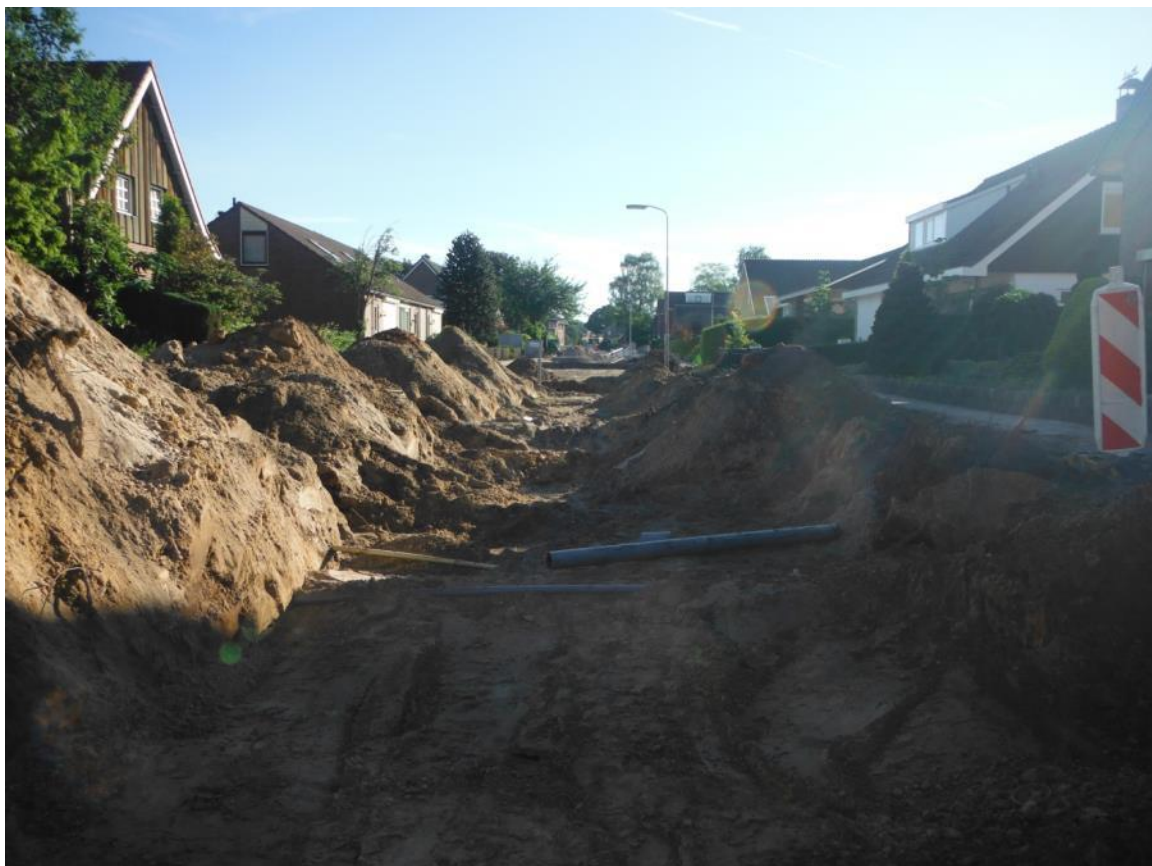
Afbeelding 89: Impressie werkzaamheden nabij profiel 41
