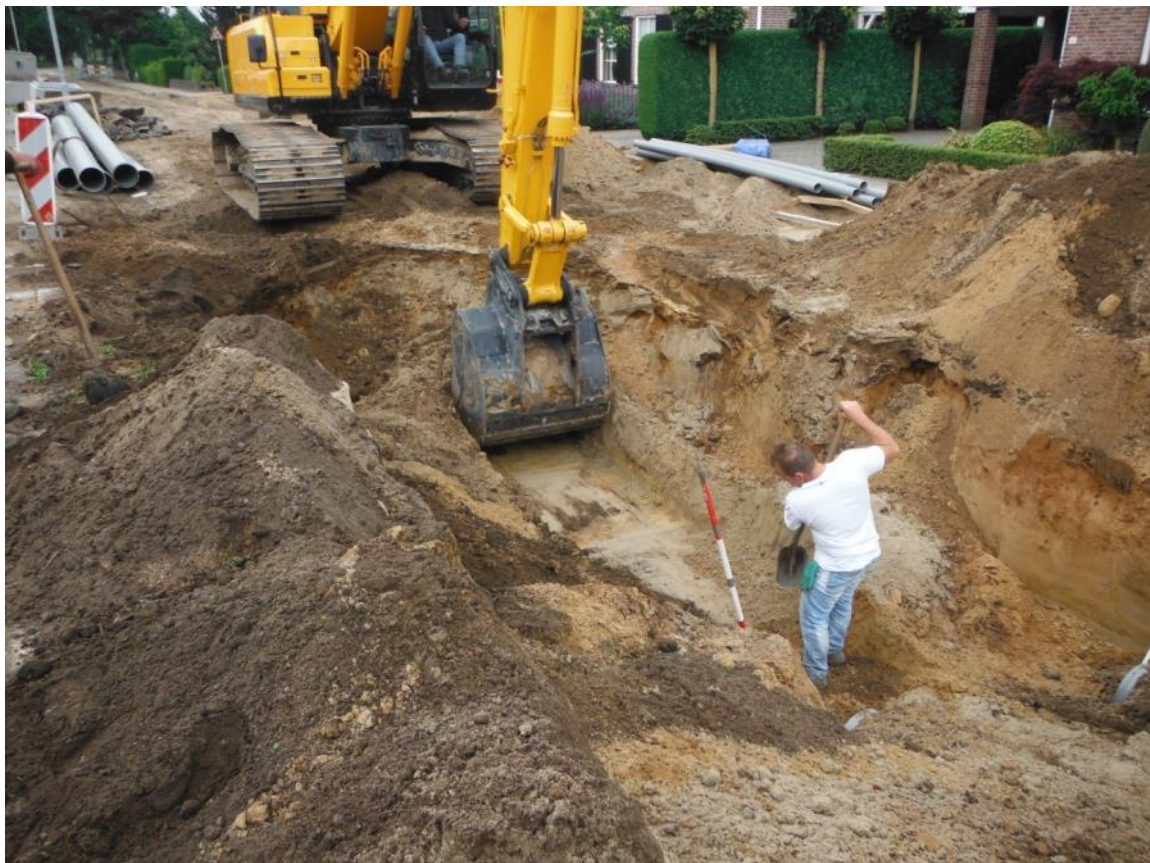
Afbeelding 71: Impressie werkzaamheden nabij profiel 32
