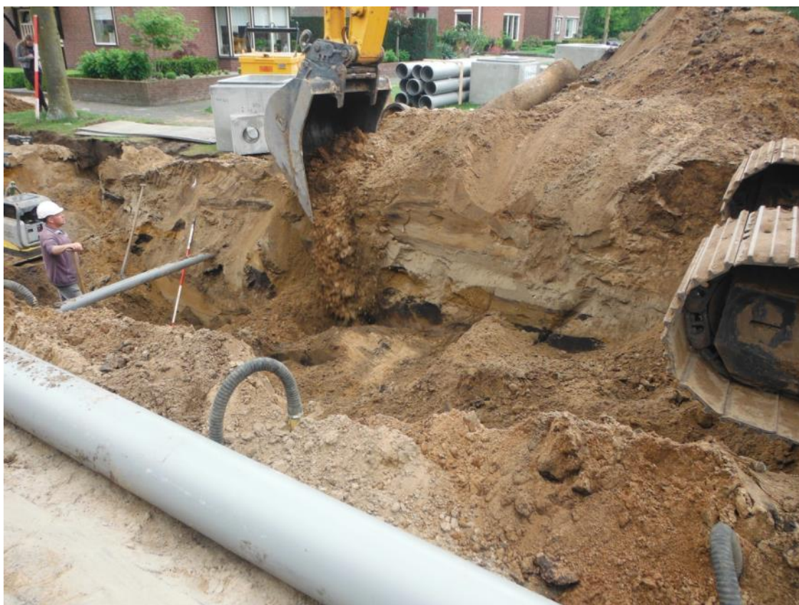
Afbeelding 41: Impressie werkzaamheden nabij profiel 17
