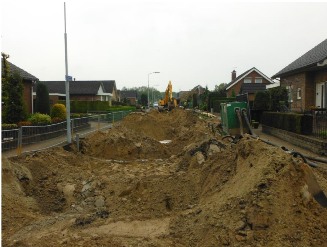
Afbeelding 21: Impressie werkzaamheden nabij profiel 7
