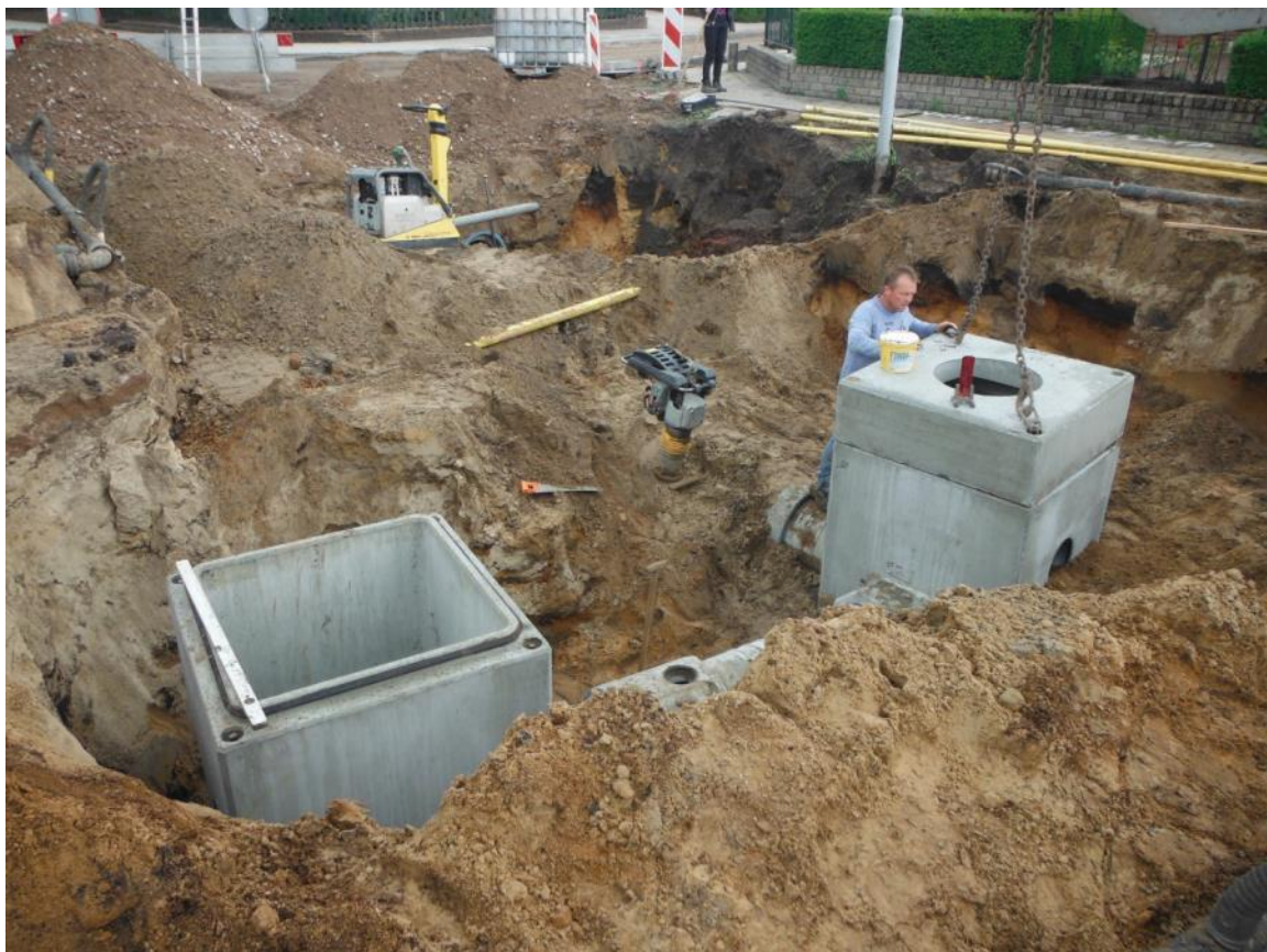
Afbeelding 85: Impressie werkzaamheden nabij profiel 39
