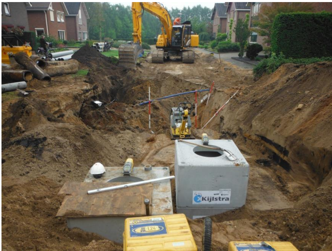
Afbeelding 45: Impressie werkzaamheden nabij profiel 19
