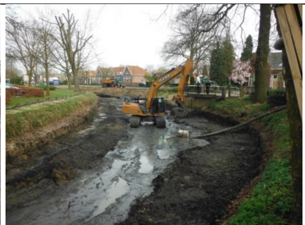
Graafwerkzaamheden oostelijke deel gracht
