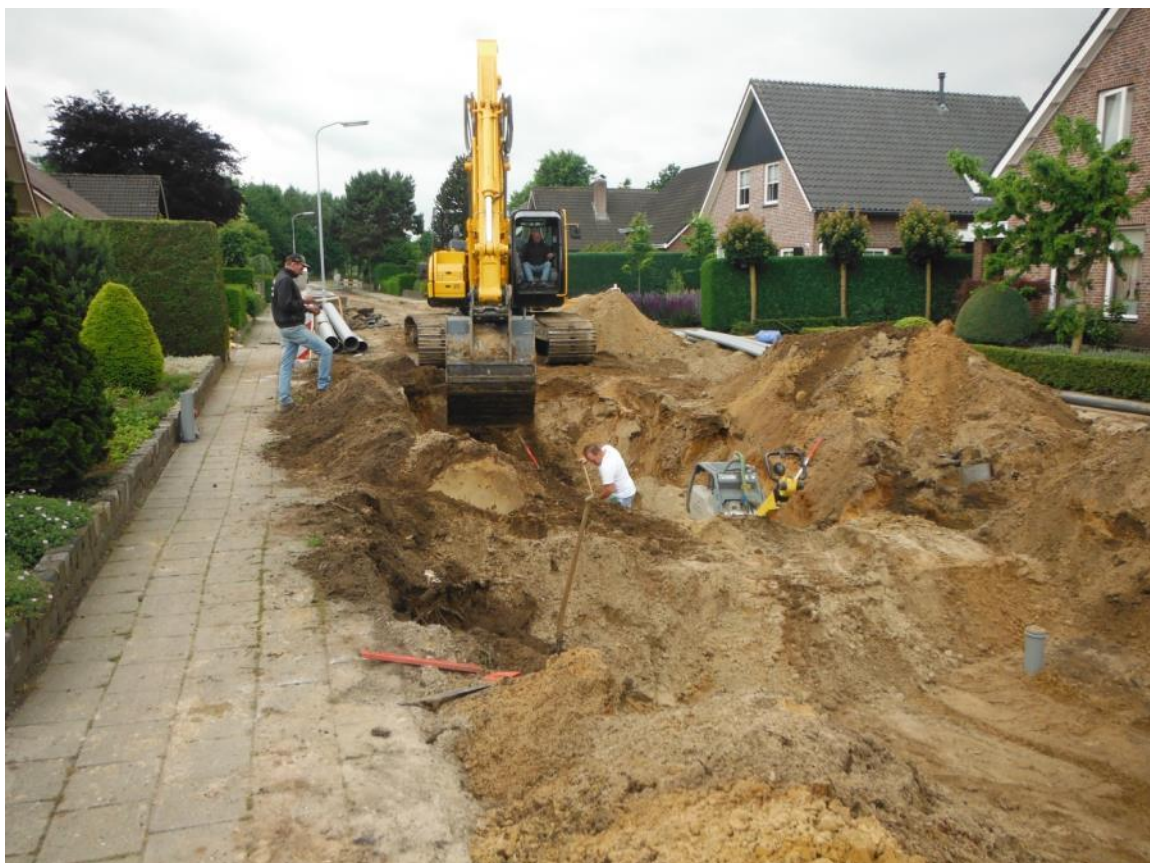
Afbeelding 87: Impressie werkzaamheden nabij profiel 40
