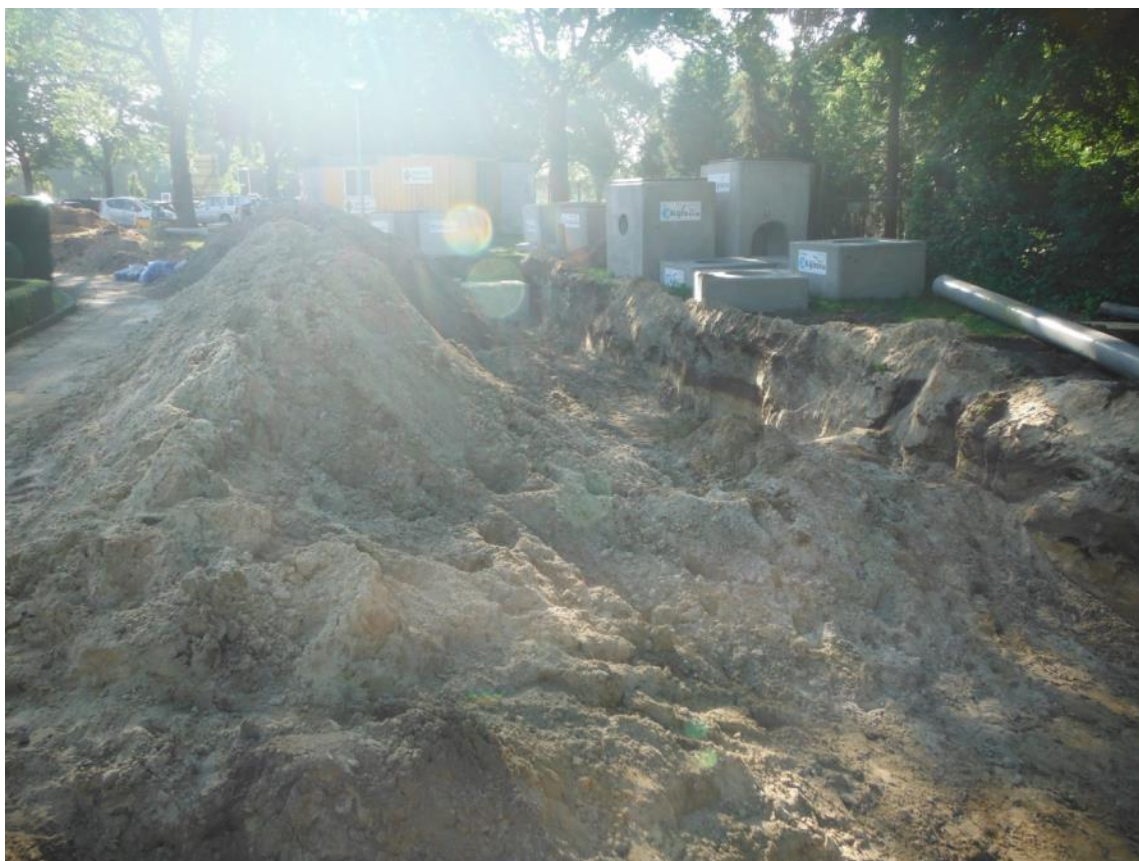
Afbeelding 59: Impressie werkzaamheden nabij profiel 26
