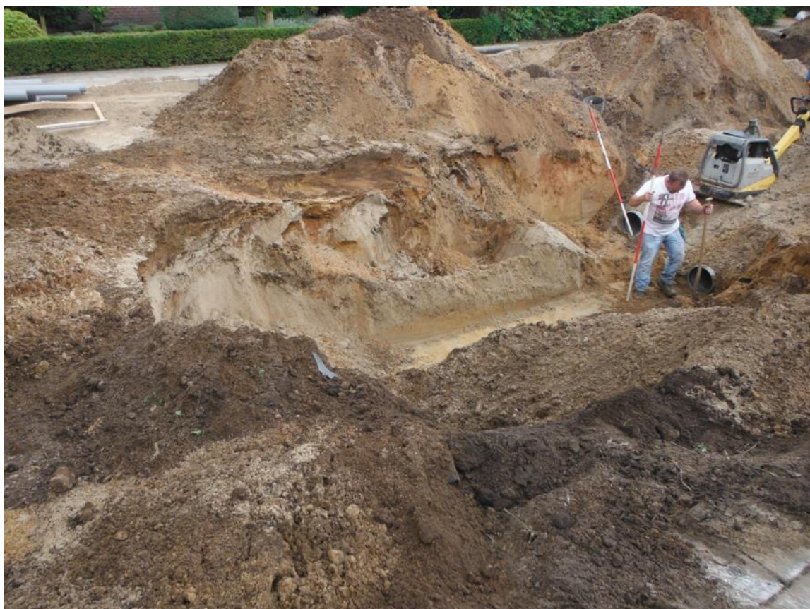
Afbeelding 83: Impressie werkzaamheden nabij profiel 38
