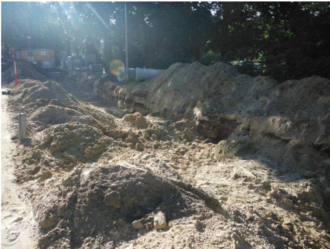
Afbeelding 55: Impressie werkzaamheden nabij profiel 24
