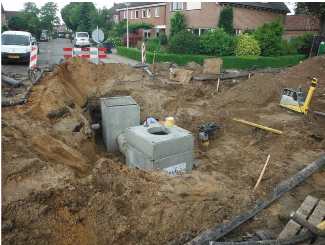
Afbeelding 67: Impressie werkzaamheden nabij profiel 30
