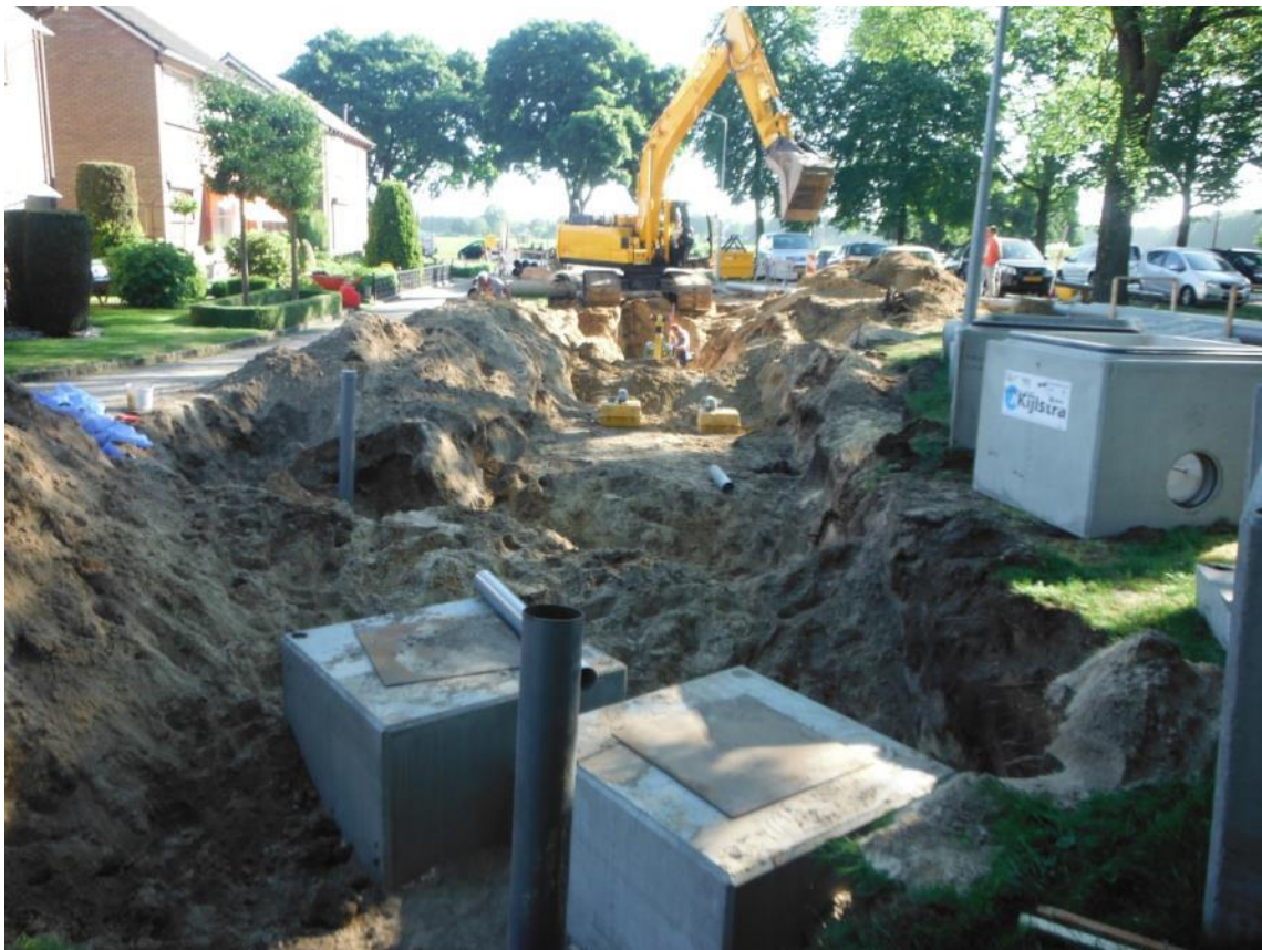
Afbeelding 63: Impressie werkzaamheden nabij profiel 28
