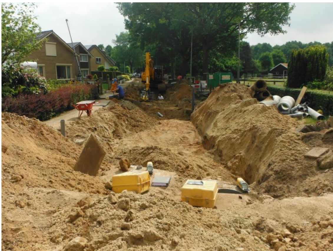
Afbeelding 53: Impressie werkzaamheden nabij profiel 23
